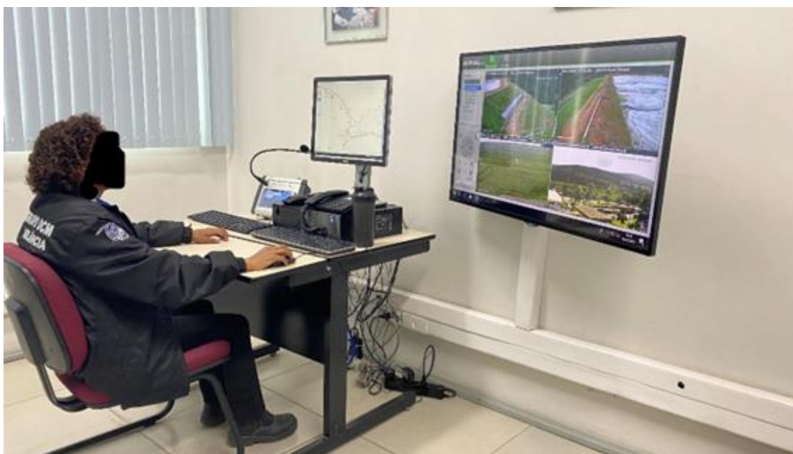
Figura 16.1 – Foto da sala de monitoramento e controle da barragem
